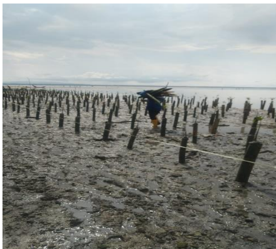
Gambar 1.3. Pemasangan Bambung Bambu
